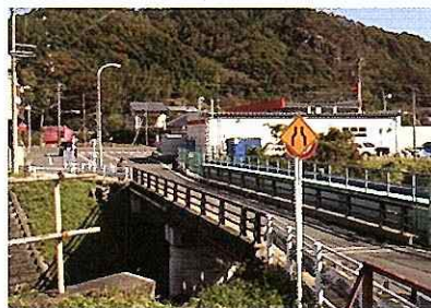
落合橋の拡幅工事
