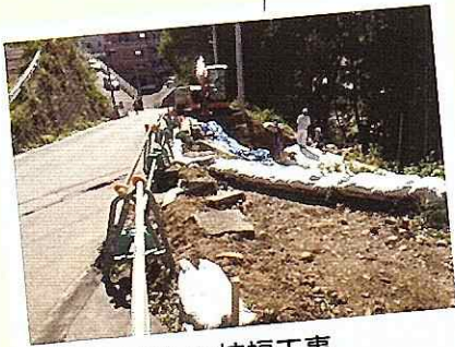
「うなり坂」の拡幅工事
